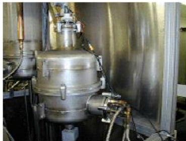
Fig. 8: Foto der Wasservorlage mit den Vakuumdurchführungen an die Spiralschlauch Wärmetauscher. Der Stutzen für die Vakuumpumpe ist oben angeordnet.
